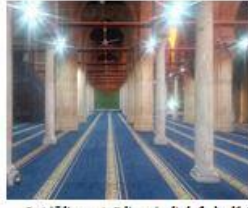
شكل ( 1 ) الجامع الأزهر – القاهرة حيث يتم تصميمه بالوحدة المتكررة ( البائكة ) التي تتكرر فتكون اروقة الصلوة
